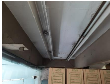
Figura 22 - Caixas de iluminação sem ligação de luminárias
