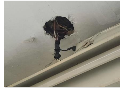
Figura 24 - Fiação com emendas sem proteção mecânica
