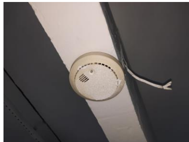
Figura 28 - Detector de Fumaça Desligado
