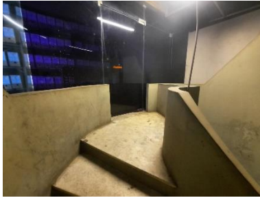
Figura 16 – Escada sem corrimão e G. C.
