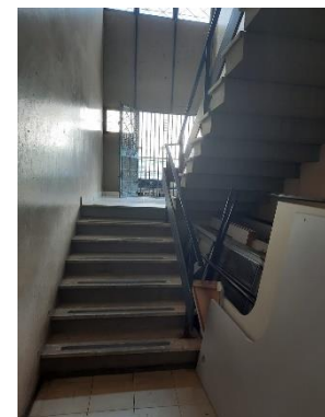
Figura 15 – Escada sem corrimão e G. C. adequados
