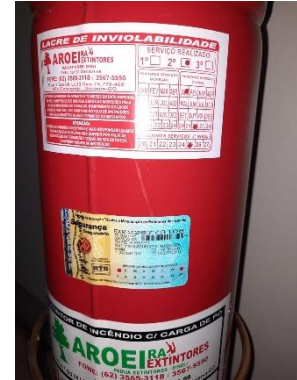
Figura 12 - Extintores com datas de manutenção vencidas
