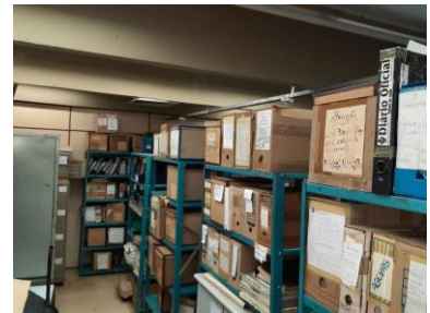
Figura 30 - Detectores Instalados em Posição Baixa
