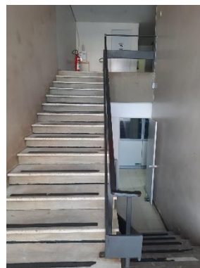
Figura 14 – Escada sem corrimão e G. C. adequados
