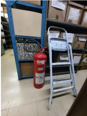
Figura 10 – Extintores Instalados no Chão, sem suporte
