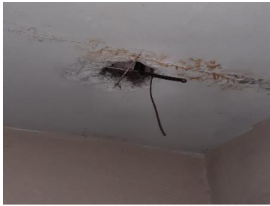
Figura 19 - Fiação solta sem qualquer ponto de ligação
