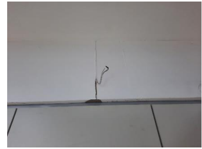
Figura 23 - Fiação solta sem qualquer ponto de ligação
