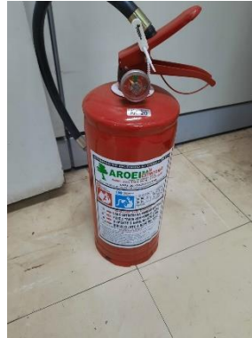
Figura 11 - Extintores Instalados no Chão, sem suporte
