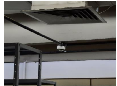
Figura 29 - Detector Instalado em Ponto Baixo
