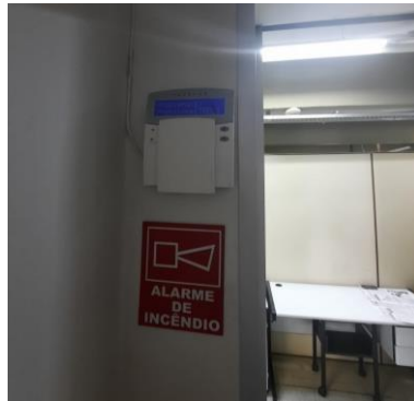
Figura 27 - Possível "Central de Alarme"
