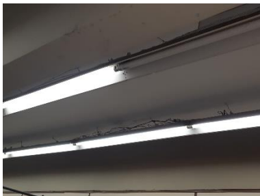
Figura 20 - Fiação acima das luminárias em proteção mecânica.
