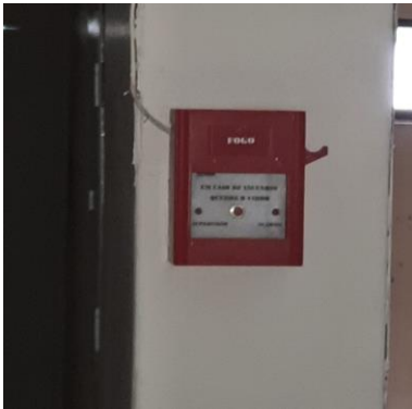
Figura 25 - Botoeira de Acionamento de Alarme de Incêndio
