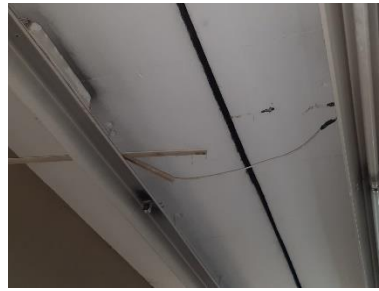
Figura 21 - Fiação aparente solta no teto
