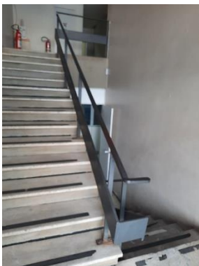
Figura 13 – Escada sem corrimão e G. C. adequados
